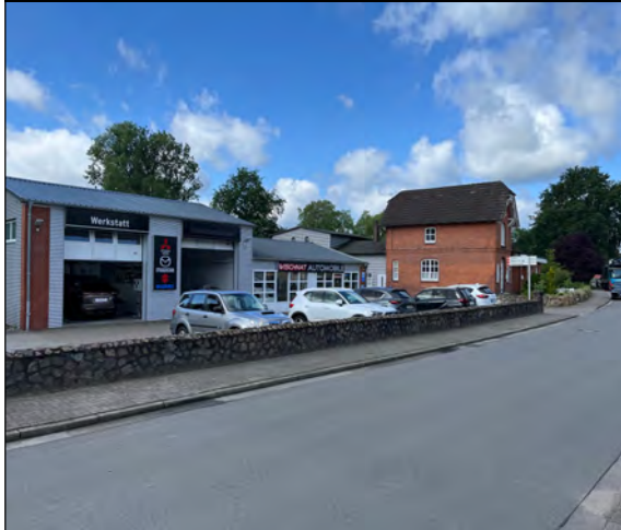
Abb. 5: Vorhandene Bebauung auf dem Grundstück Eikhof 20 von Nordosten
