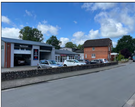
Abb. 5: Vorhandene Bebauung auf dem Grundstück Eikhof 20 von Nordosten
