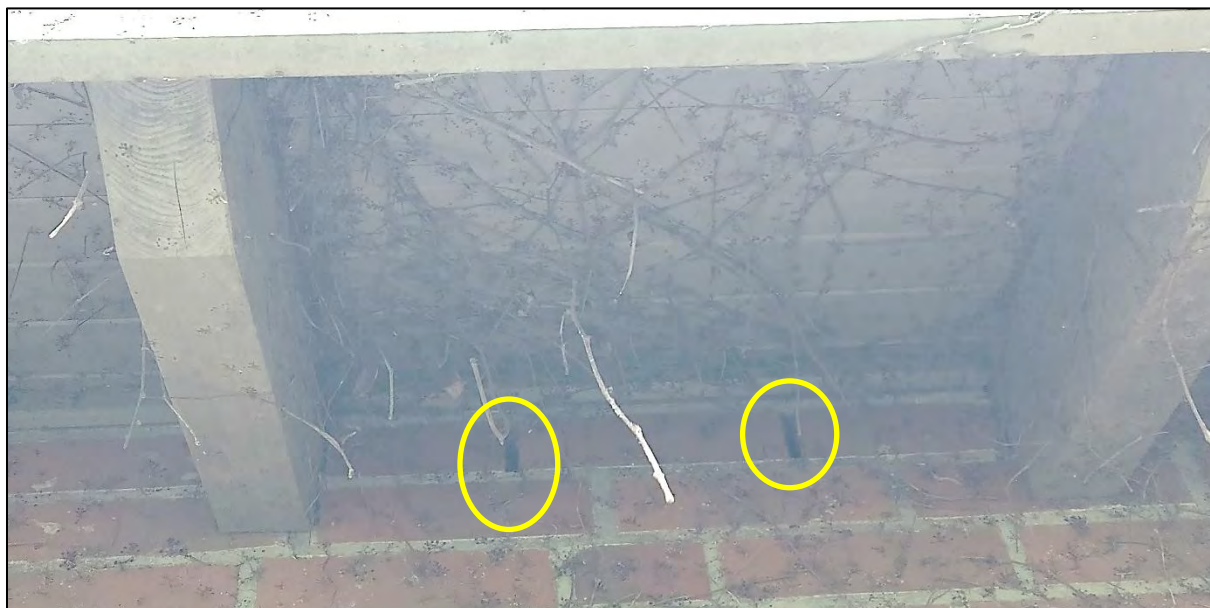
Gebäudenischen unterhalb der Dachfassade
