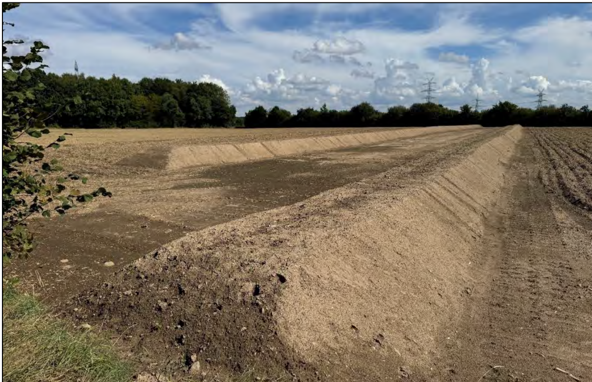
Neu angelegter Doppelknickwall Ende August/Anfang September 2025
