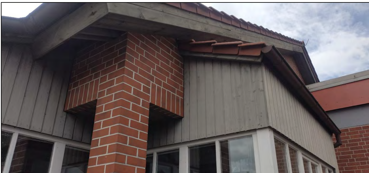
Gebäudenischen unter den Holzfassaden eignen sich für Tagesquartiere und Wochenstuben von Fledermäusen und können Bruthabitat für an Gebäuden brütende Vögel darstellen.
