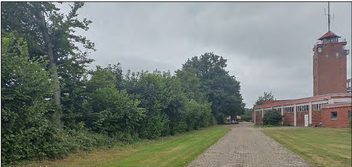
Knicks entlang der westlichen Grenzen des Feuerwehrgrundstücks
